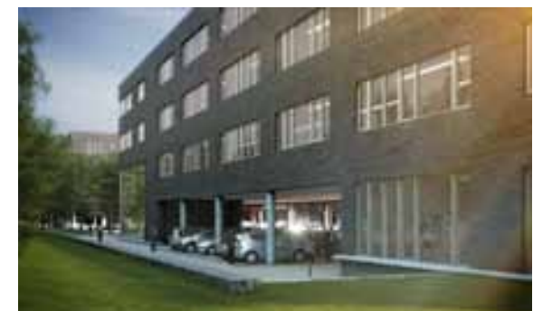
Rond het parkerveld ligt een keermuur van schanskorven.
