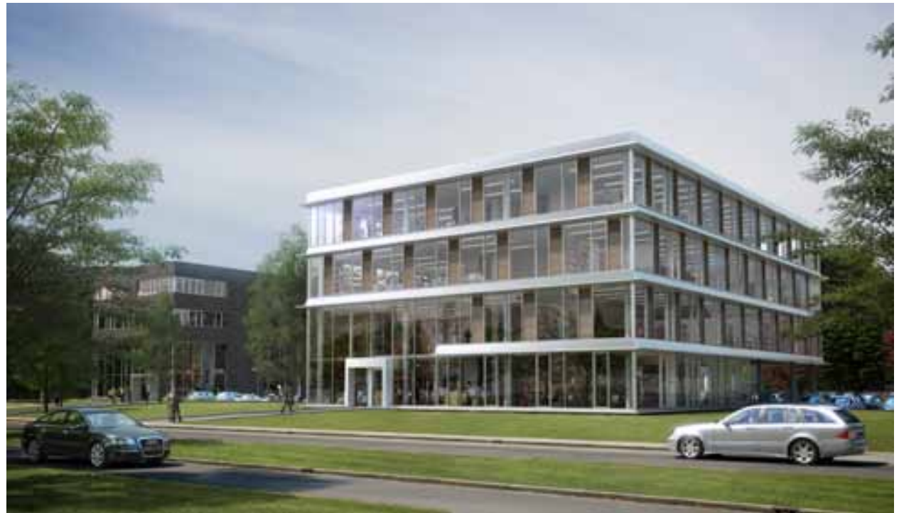
Gevels paviljoen met een sterke horizontale geleding door middel van polyester vinnen.
