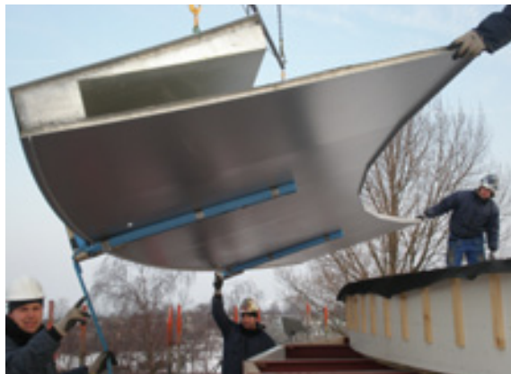
Het plaatsen van de omlijsting van de nieuwe 2e verdieping
