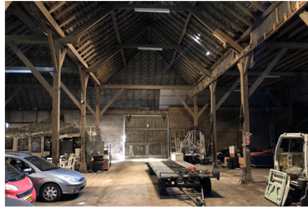
Interieur van de schuur met de oude houten draagstructuur
