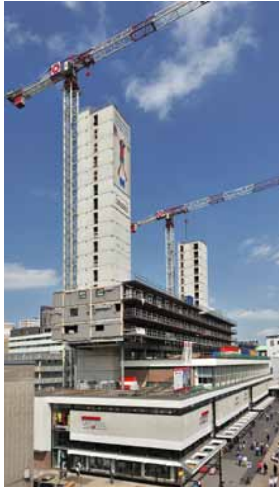
Bouwfoto juni 2010 - De betonnen kernen zijn op hoogte
