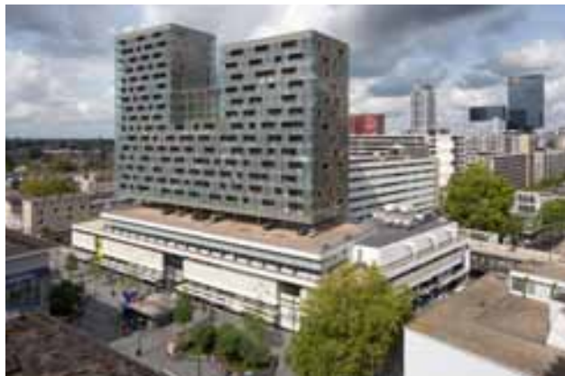
114 Appartementen boven het voormalig Ter Meulen.
