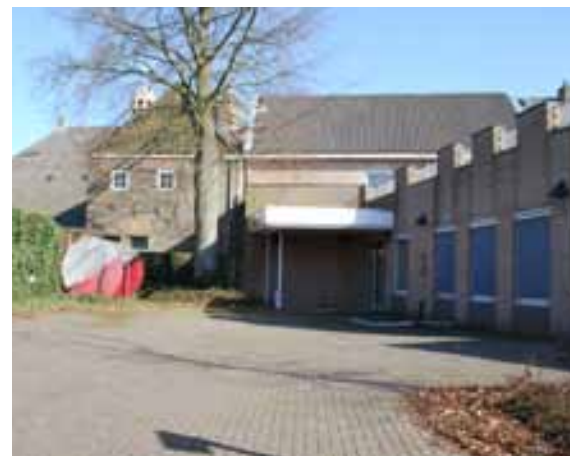
Huidige achterzijde ING kantoor.
